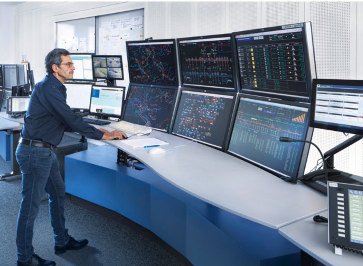
Surveillance du réseau de distribution de BKW depuis le centre d'exploitation de Mühleberg.
